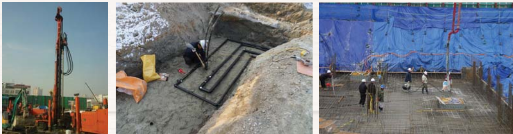
[그림1] 포스코그린빌딩의 주요 시공기술 (좌:지열시스템 천공, 중:지열시스템 배관작업, 우:친환경콘크리트 타설)
