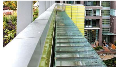
특수빗물수집구조물이 설치 된 지붕과 난간
