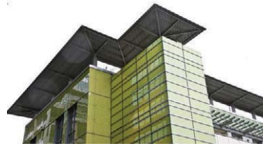
특수빗물수집구조물이 설치 된 지붕과 난간
