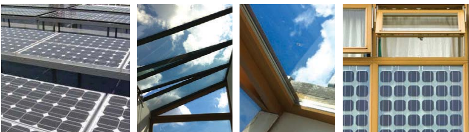
지붕 태양광집열판 & 태양광 창문(PV cells)
