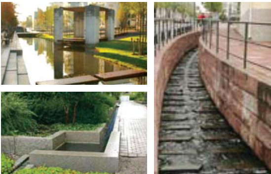
도시 곳곳에 배치된 수로 채널 (Storm water Channe)
