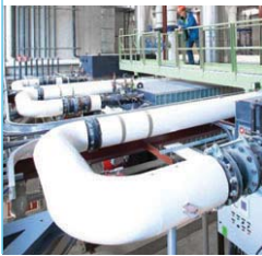
선수촌 하수여열회수시스템(sewer heat recovery system)
