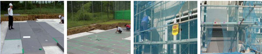
[그림1] 바닥 및 외벽부위 단열공사
