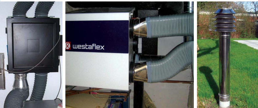
[그림3] 전열교환환기시스템 및 지중덕트 공기도입부
