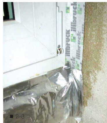
[그림2] 기밀시공사례 2-1, 콘센트박스 기밀 2-2, 천장부위 기밀테이핑 2-3, 창호주변 기밀시공
